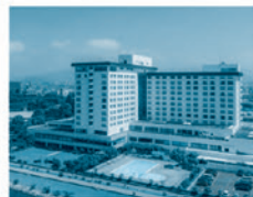
⑭ Hotel & Resorts NAGAHAMA(滋賀県) 〒526-0066 滋賀県長浜市大島町38 TEL: 0749-64-2000
